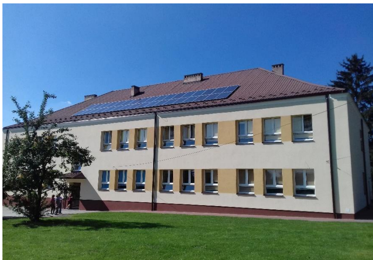
Budynek Samorządowej Szkoły Podstawowej w Bejskach po termomodernizacji.
