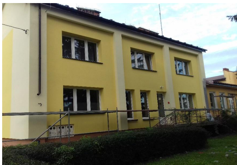
Budynek Ośrodka Zdrowia w Bejskach po termomodernizacji.
